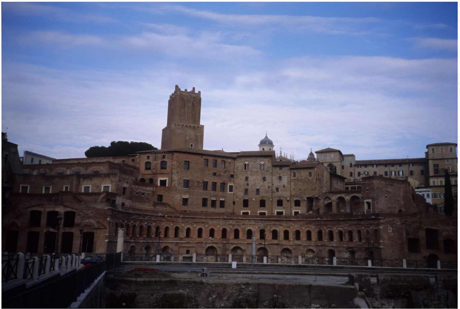
Rome, Via dei Fori Imperiali, view of Mercati di Traiano. (C. Bellanca 2003).
