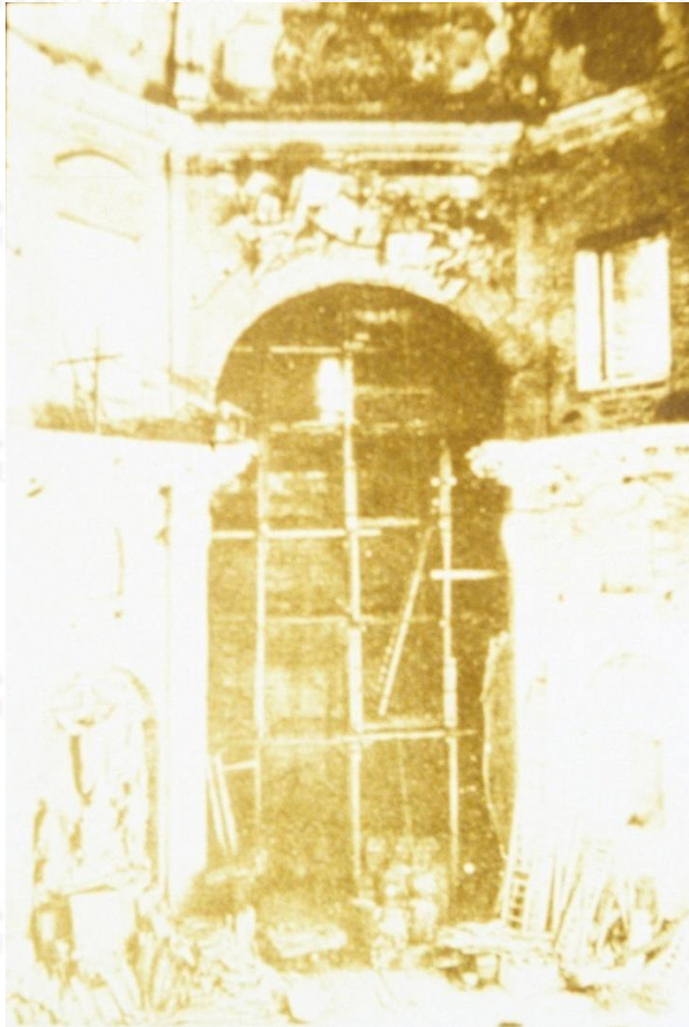
Palermo, Church of San Salvatore, war damage (Soprintendenza Beni architettonici e ambientali Palermo)
