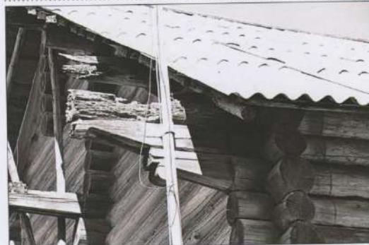
*Particolari costruttivi del sistema di travi a sbalzo di sostegno per la pesante copertura a capanna.*
