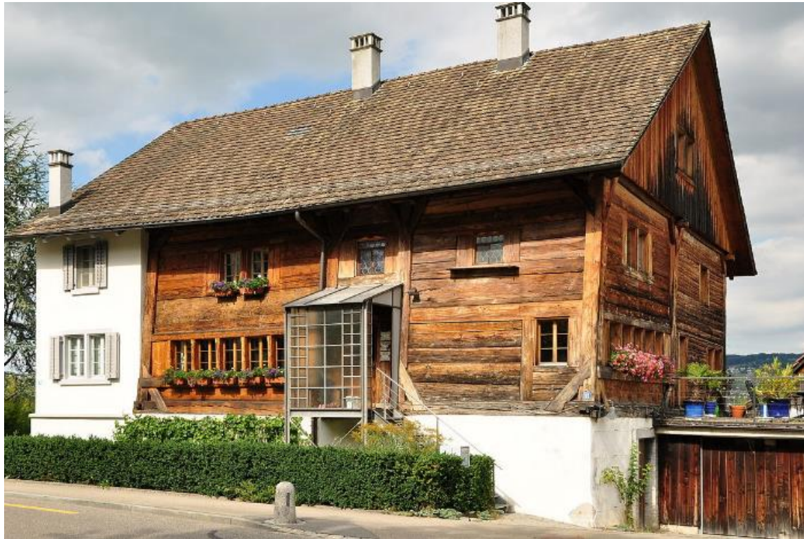
Fot.20. Dom z konstrukcją sumikowo-łątkową w Oberrieden (Szwajcaria) źródło: wikipedia
