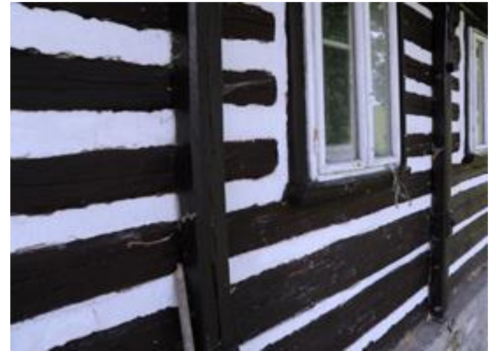
Photo. Wall construction with ticks. Source: architektura.knap.cz Źródło: architektura.knap.cz
